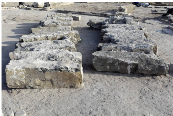
图六 西山坡一号塔基砖筒底部平铺石柱结构
